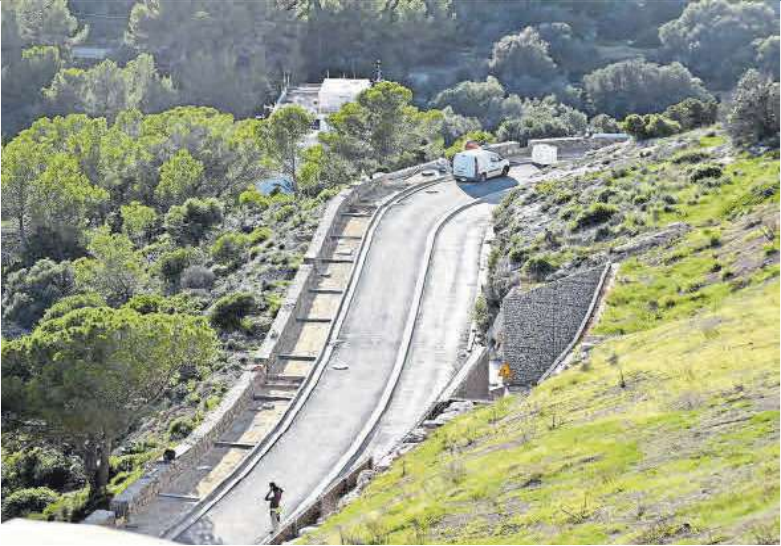
Imagen de archivo de las obras del Camí del Calvari.
